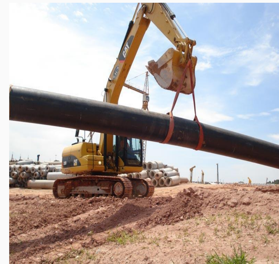
F.O. em Gasoduto e Oleoduto
